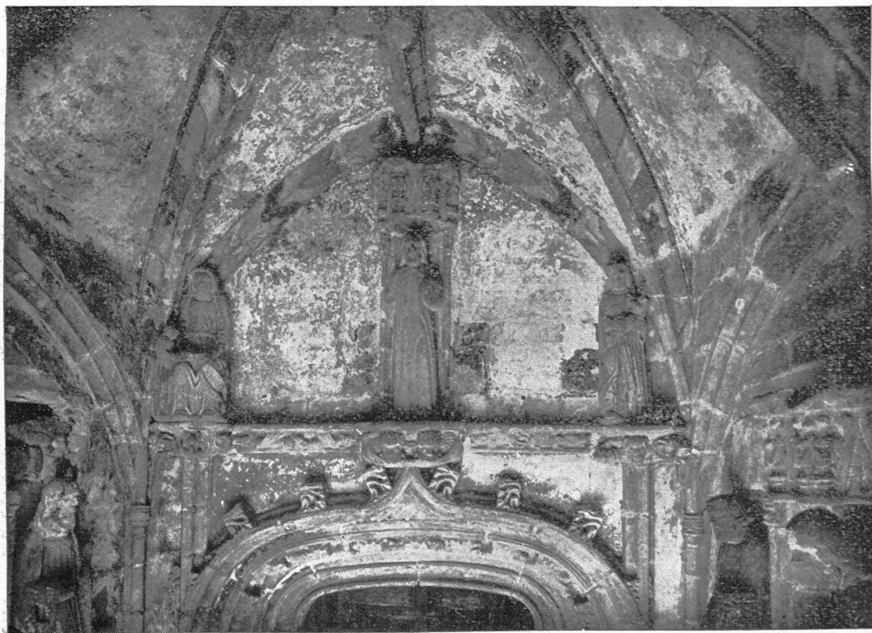
INTÉRIEUR DU PORCHE MÉRIDIONAL.
